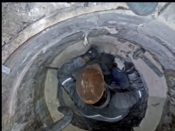
解体調査 湯差しの検証 (ルツボ型誘導炉)
