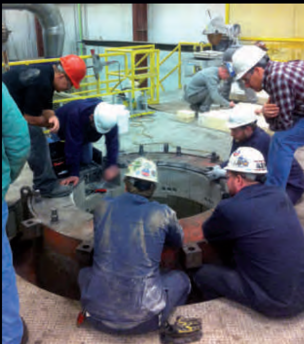
ユーザーへの技術指導：電極プレート取り付け
