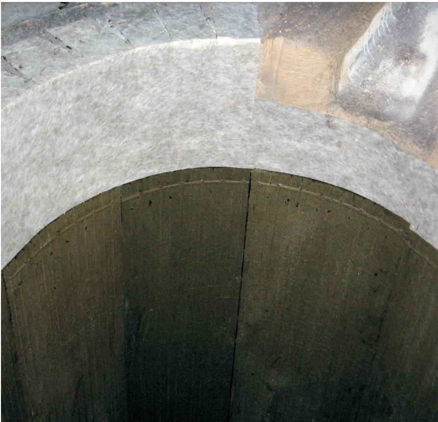
▲ Plaques à électrodes installées dans un four à creuset à induction
