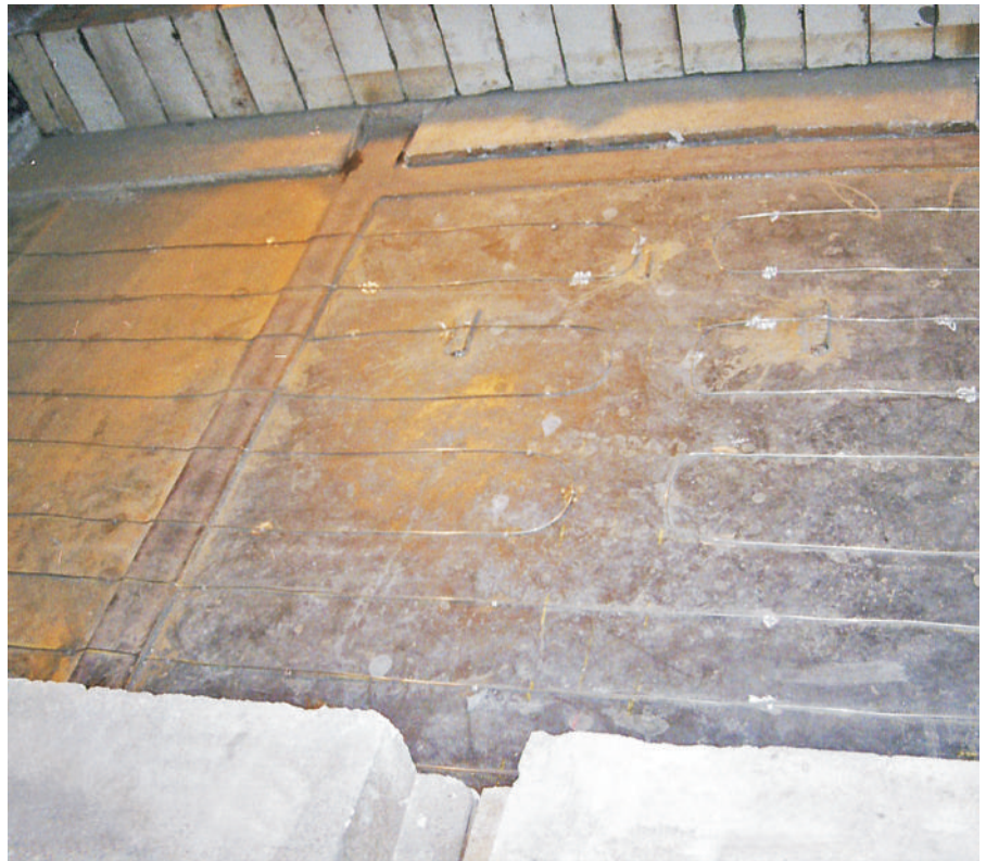
▲ Installation des capteurs SAVELINE sur l'intérieur du manteau d'acier d'un condenseur en zinc
