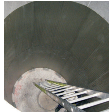
▲ Installation permanente des tiges de raccordement SAVEWAY dans le secteur du fond du four
