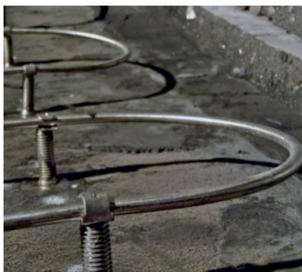
▲ Installation des capteurs SVELINE
