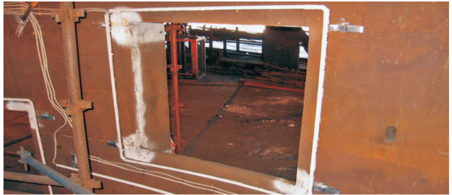
▲ Disposition des capteurs SAVEDRY dans un cadre métallique préfabriqué sur le trou de percée d'un four à arc électrique
